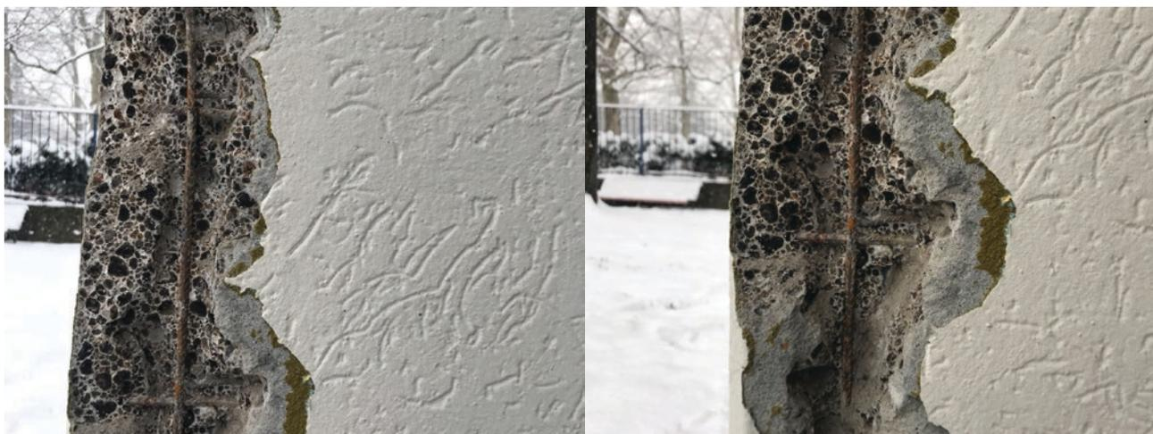
Fotografia 31. rilievo armatura pannello (1).
